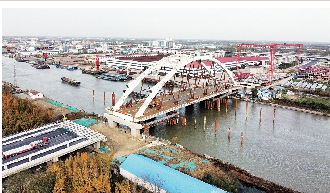
日前,由百崮公司自主承接的泰州青年路北延新通扬运河桥整体顶推施工顺利完成,得到了业内一致认可,省、市住建系统、业主方多次组织相关人员现场观摩。 本报记者 宗秋斌 摄影报道
